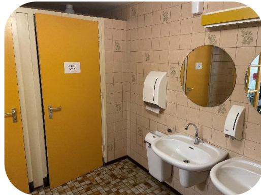
Toiletten zijn verouderd en stromen veelal door
