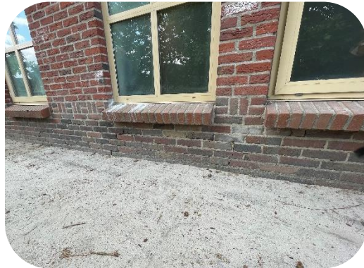
Schade aan metselwerk (beperkt)
