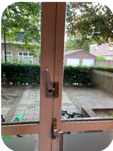
Kozijnen zijn van aluminium en sluiten slecht. Op sommige plekken vallen ramen open bij het passeren van een vrachtauto
