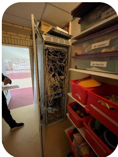
Locatie patchkast in berging speellokaal niet gewenst
