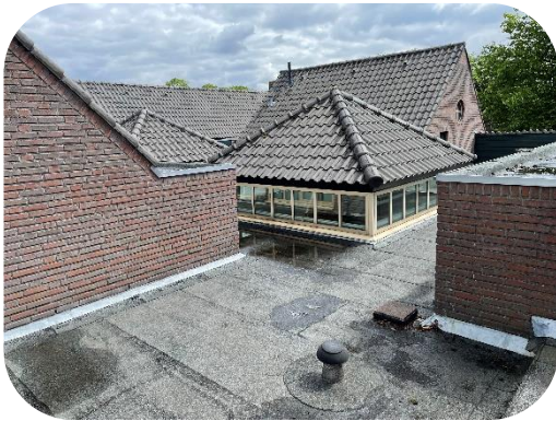
Minimale opstand bij kozijnen. Inpandige hemelwaterafvoer
