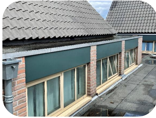
Minimale opstand bij kozijnen. Inpandige hemelwaterafvoer
