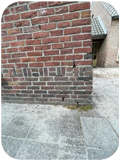
Schade aan metselwerk (beperkt)
