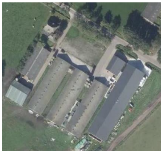
Luchtfoto bestaande situatie
